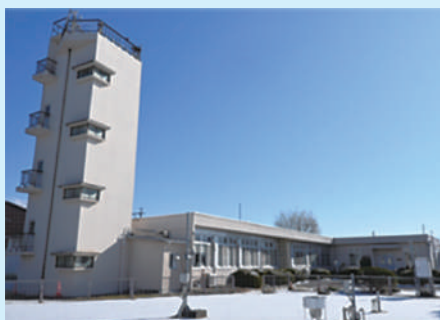
長野市にある長野地方気象台の庁舎
