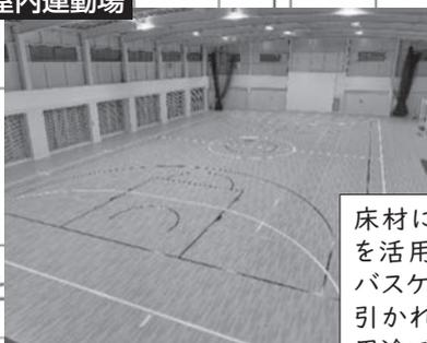
床材に長尺弾性塩ビシートを活用。フットサル、テニス、バスケットボールのラインが引かれており、多様な種目・用途で活用いただけます。
