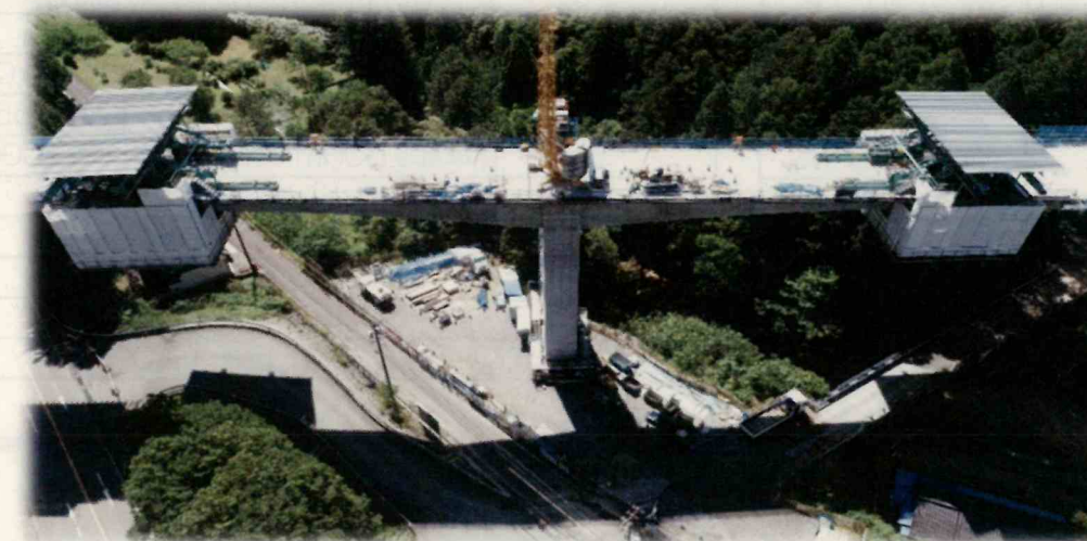
進捗R5.5月 (P3張出施工中)
