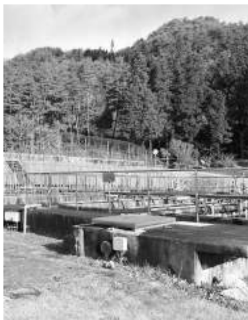
イエローゾーンに指定されている堂所浄水場
