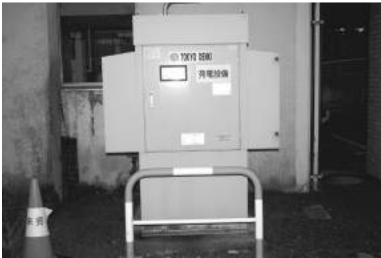
修理が行われる役場非常用発電機
