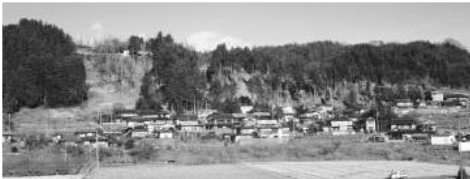
山吹城坂線を国道153号線から望む
