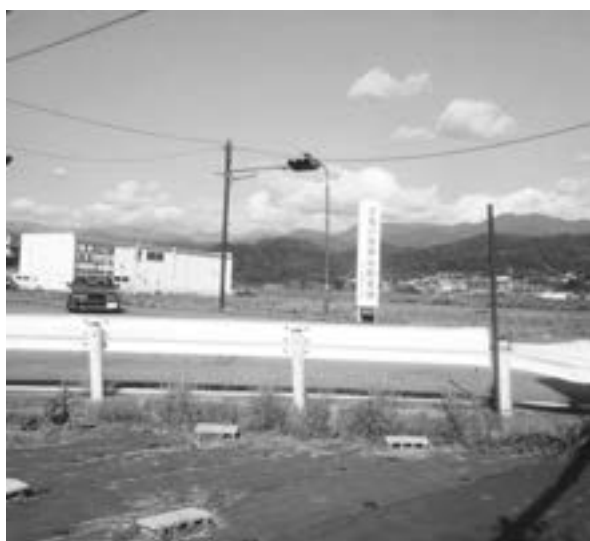
竜神大橋建設予定地
