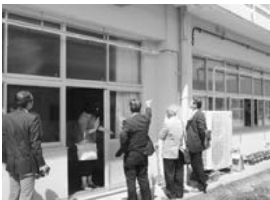
配管を終えた北小学校普通教室
