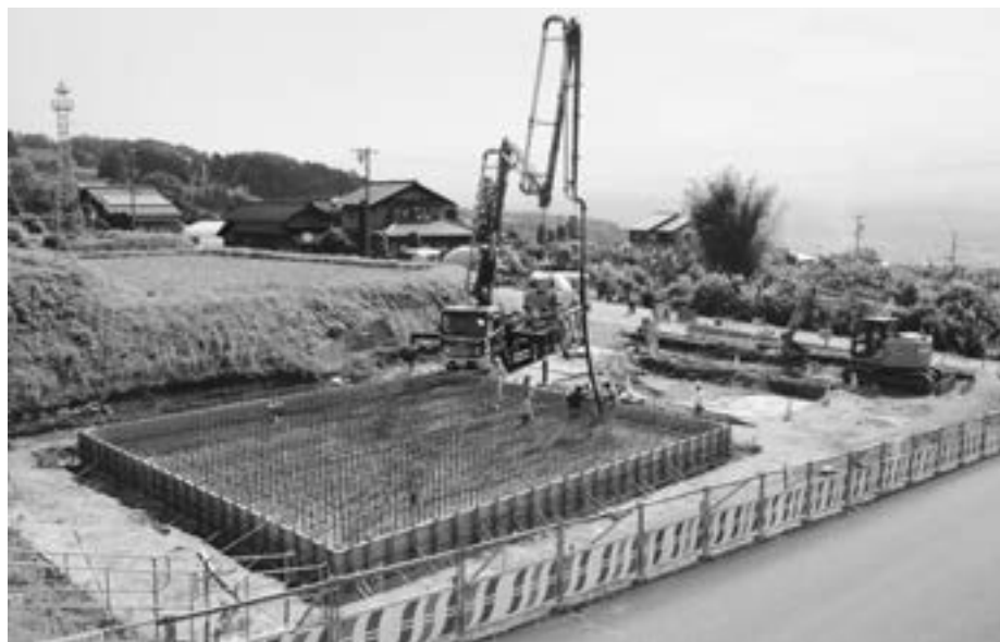
進む「新鬼の手配水池工事」
