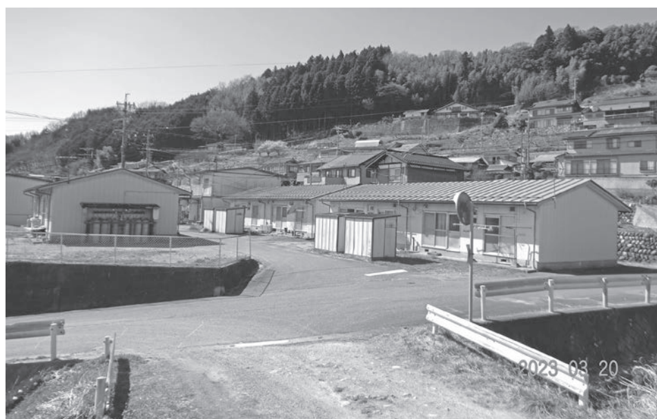
RC 4階建てに改修提案した現在の町営山吹団地
