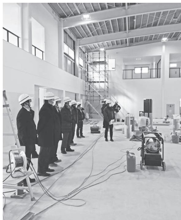
建設中の屋内運動場を視察
