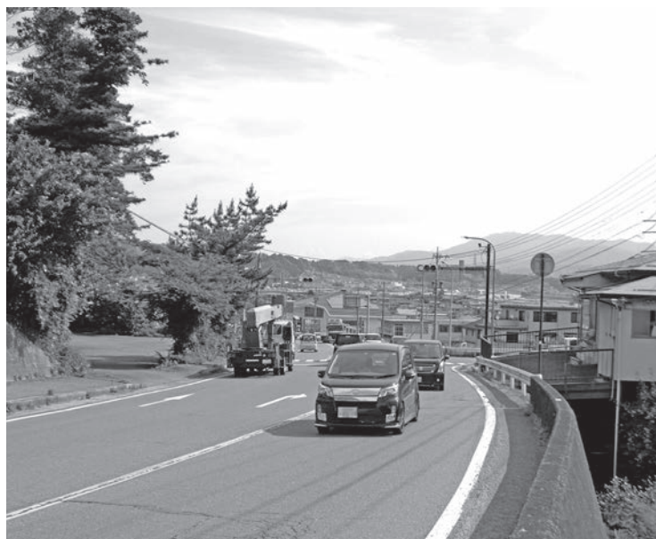
国道153号線 町内の現状
