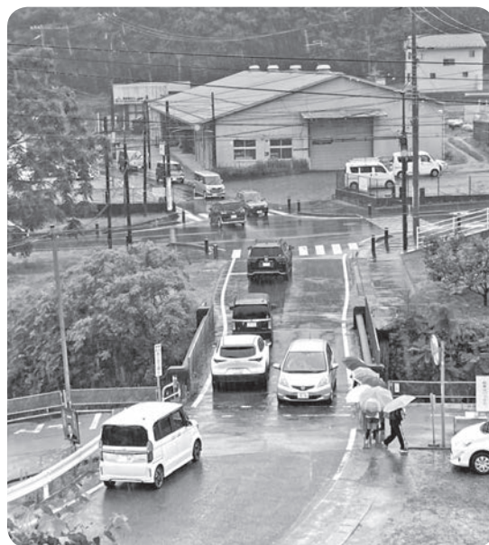
城岸橋の通学時間帯の様子
