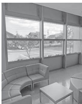
断熱改修された外来受付周り
