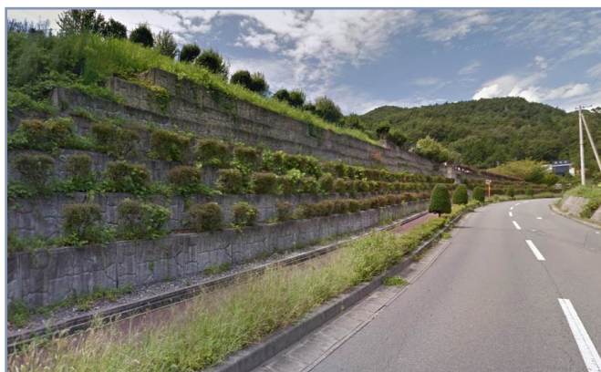
〔景観に配慮した擁壁〕
