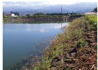
駒場温水ため池
