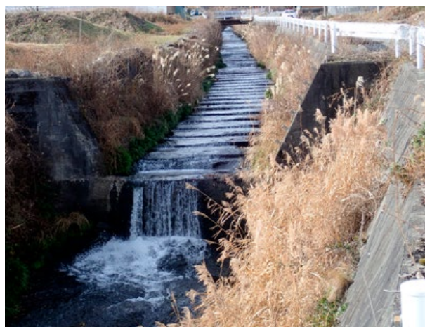
コンクリート護岸、床固工が整備された田沢川（撮影：大原均）
