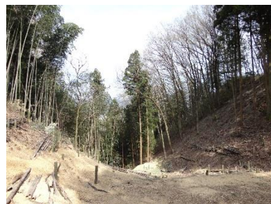
（令和4年度施工後）
