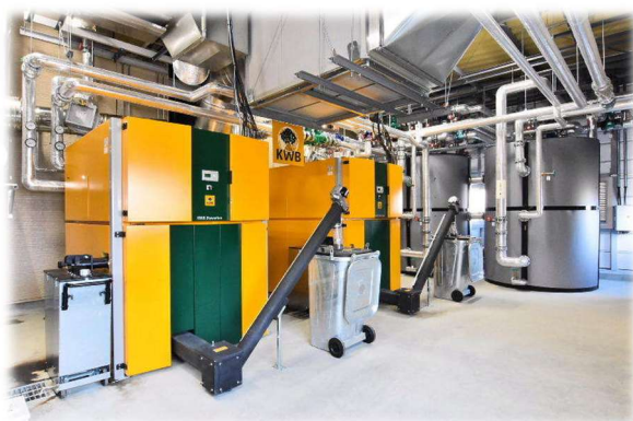
信州たかもり温泉の地域産木質チップ を使った給湯用バイオマスボイラー
